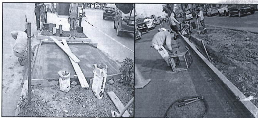
Gráfico N.º 039: Trabajos Realizados en la Berma de la Ant. Panamericana Sur, Mantenimiento de Veredas, Colocación de Bolardos, Instalación del Sistema Eléctrico y/o Reflectores, Zona "B"
