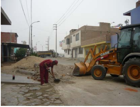
Evacuación de desmonte en vía pública
