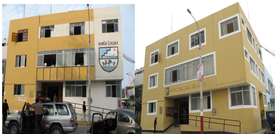
Frontis de la Municipalidad de Lurín antes y después de su mantenimiento “Mejoramiento y Enripiado de vías de acceso de las cinco zonas del Distrito A, B, C, D y E” Monto Ejecutado: S/. 116,312.75 Población Beneficiada: 2600
