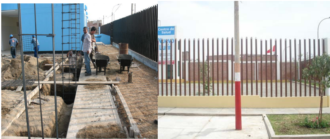
Construcción de veredas en el Centro de Salud de Km. 40
